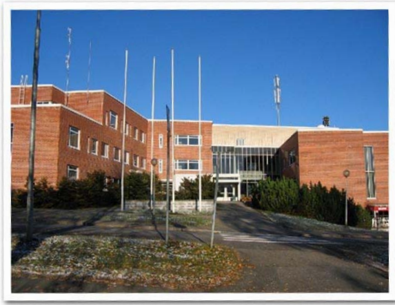
Kuva: Mikkelin maalaiskunnan uusi kunnantalo valmistui Rantakylän taajamaan keväällä 1989. Kunnan lakkauttamisen jälkeen rakennus on tunnettu Rantakylä-talona. Tiloihin on sijoitettu Mikkelin kaupungin virastoja.
